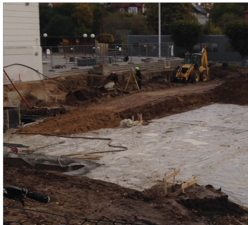
Jordforberedende arbejde og sokkelarbejde er påbegyndt.
